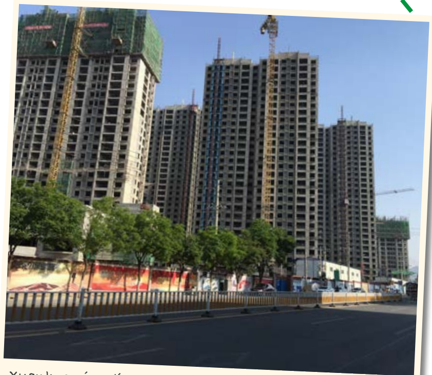
Xuanhua, eine dieser Städte in China, die innert kürzester Zeit wie aus dem Nichts entstehen.
