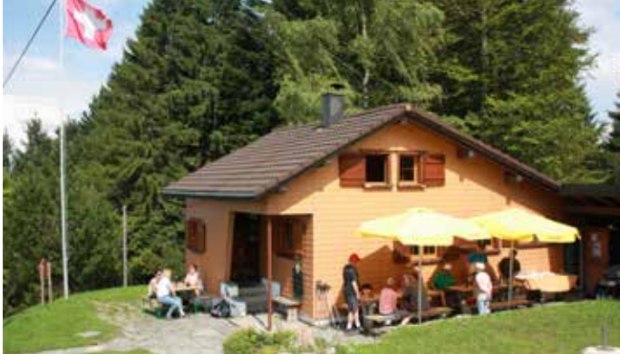
Jetzt auch mit saniertem Dach: Naturfreundehaus Waldeggli.
